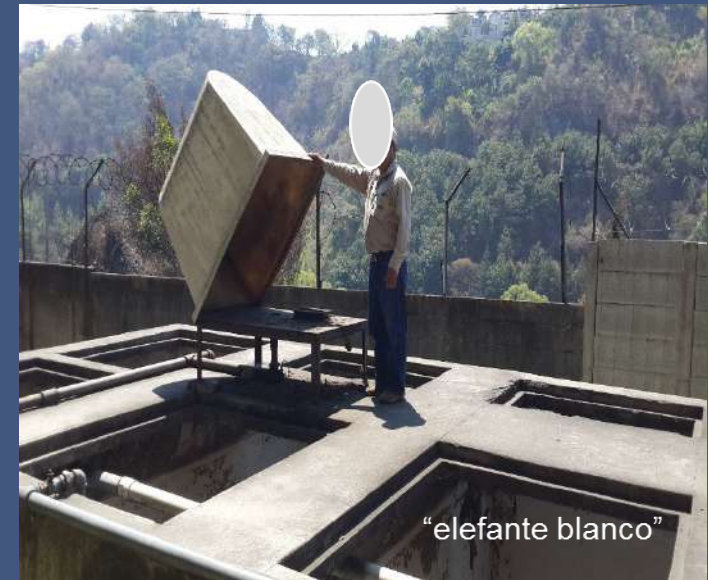
Planta de tratamiento de lodos activados (aireación extensiva), Villa Nueva - Guatemala
