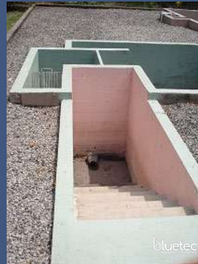
Patio de secado desarenador. Parque Acuático AquaVentura, Masagua - GT
