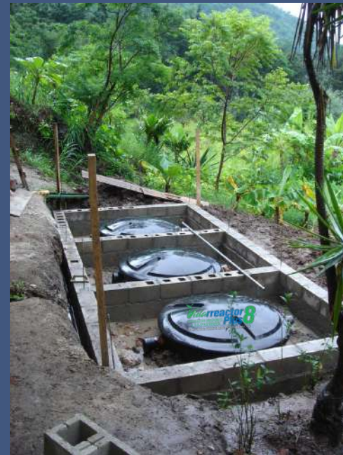
Tres sistemas de 2.0 M3 instalados en las cabañas de la Reserva Natural Atitlán, Panajachel, Sololá.
