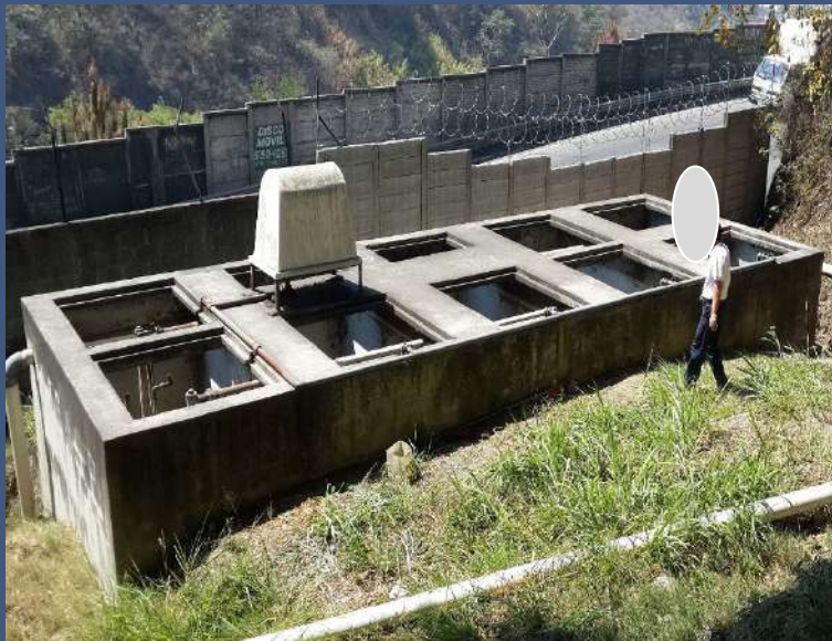
Planta de tratamiento de lodos activados (aireación extensiva), Villa Nueva - Guatemala
