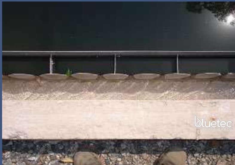
Salida de agua por vertederos
